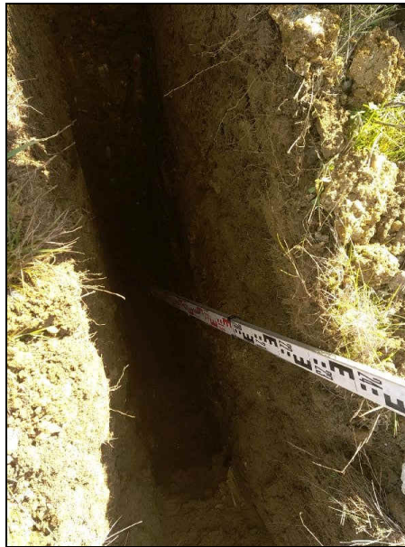
Sol : Grave argileuse fouille en P3
